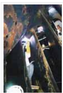
Figura 1 - Soldadores entre as pás de uma turbina hidráulica da Unidade Geradora de Salto Santiago – Tractebel Energia
