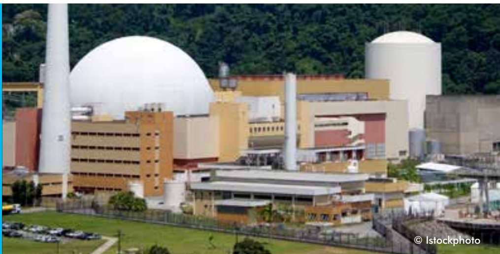
Usinas nucleares de Angra 1 e 2, na praia do Itaorna, município de Angra dos Reis (RJ)
