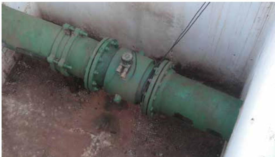
Figura 8. Medidor de vazão eletromagnético de Campo Grande.
